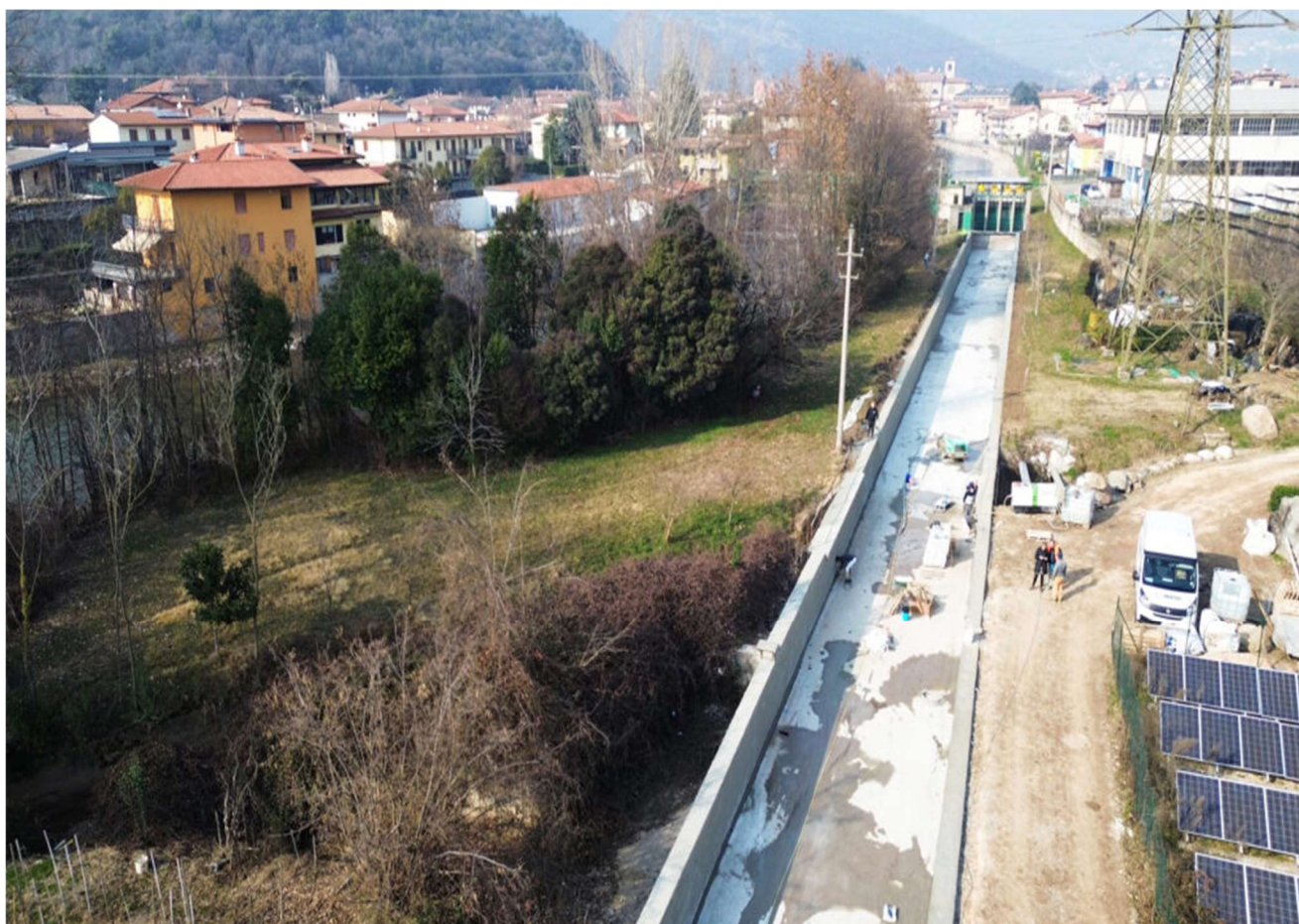
Fig. Lavori c/o la centrale
